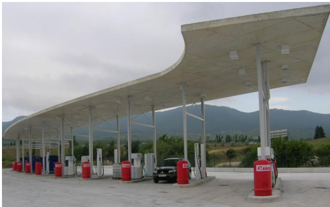
Foto: instalación de equipo DEXA.
